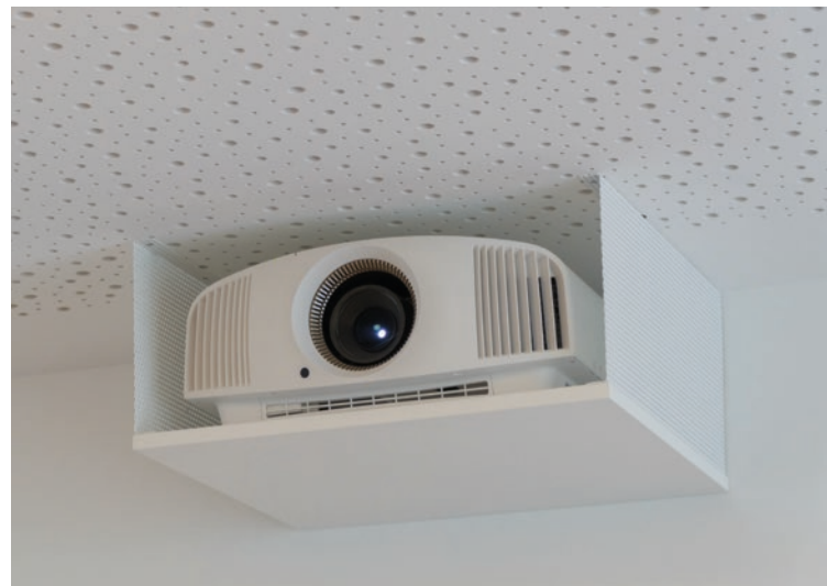
Lochblech sorgt für ansprechende Optik, aber auch für gute Durchlüftung des Projektorgehäuses unter der Decke
