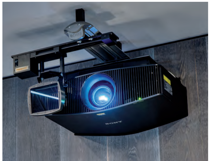
Für die Bildqualität im Diamond-Room hat das HiFi Forum aus dem Vollen geschöpft. Die Kombination aus Sony Laser-Beamer, Panamorph Anamorphot, Lumagen Scaler und Stewart Screen (curved & maskierbar) stellt eine in Deutschland aktuell einmalige Konstellation dar.
