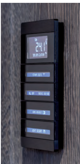
Das Touchpanel für die integrierte EIB/KNX-Haussteuerung.
