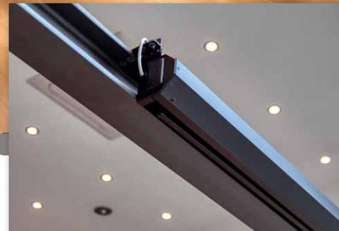
Ein oben im Raum verbauter Stahlträger ist der perfekte Ort für die versteckte Montage der Leinwand. Zum Einsatz kommt eine Stewart Phantom HALR mit Motorsteuerung
